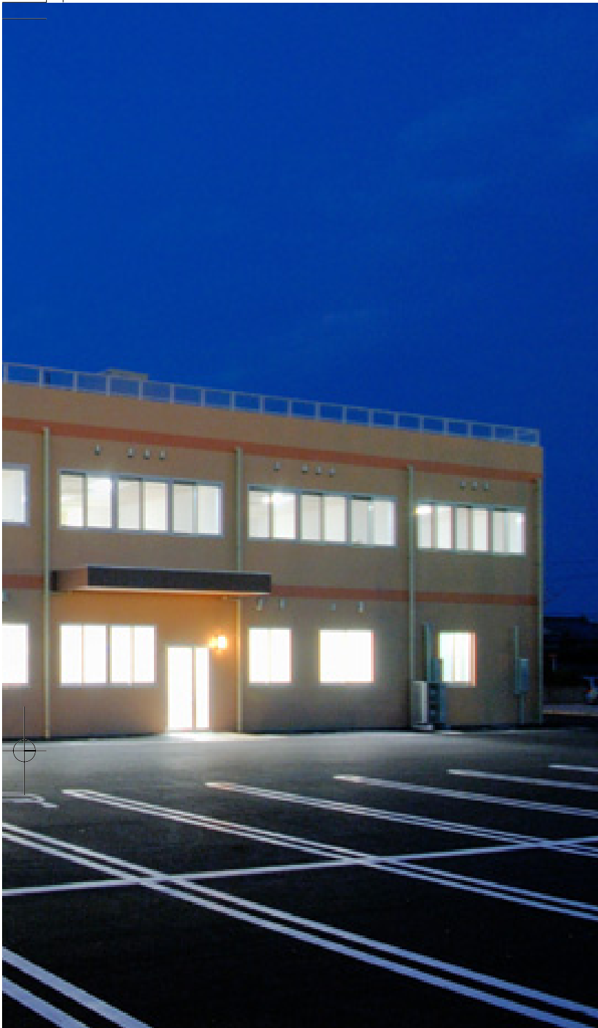
鳩の糞による感染症防止のためベランダを取り付けずシンプルな構造としている
